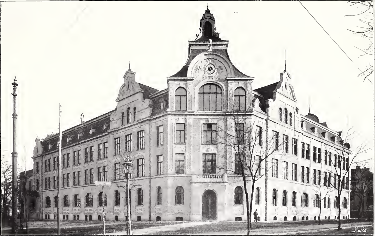
Das neue Schulhaus vor dem Roten Thor.
